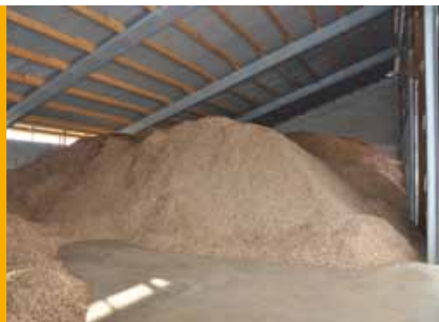
1600 Kubikmeter Hackschnitzel können gelagert werden. Bisher wurden 400 Kubikmeter verbraucht.
