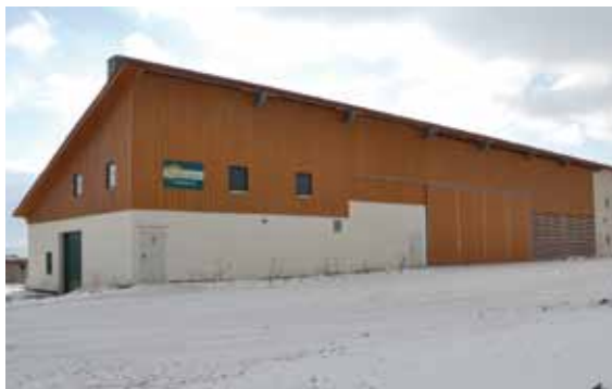
Die Halle der Bioenergie mit Brenner- und Lagerraum.
